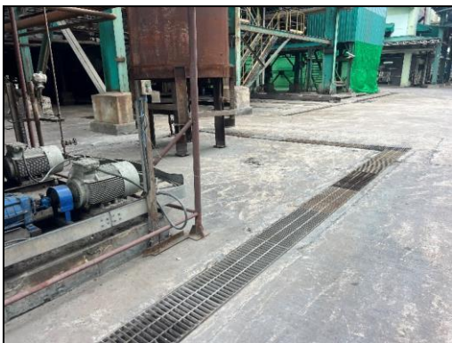
รูปที่ 15 รางระบายน้ำฝนไม่ปนเปื้อน
