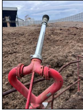
รูปที่ 8 ระบบหัวพ่นน้ำ (Sprinkler) และท่อน้ำดับเพลิงรอบกองขานอ้อย
