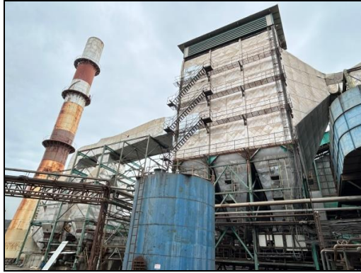
รูปที่ 1 ระบบดักฝุ่นแบบไฟฟ้าสถิต (ESP)
