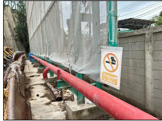
รูปที่ 8 ระบบหัวพ่นน้ำ (Sprinkler) และท่อน้ำดับเพลิงรอบกองขานอ้อย
