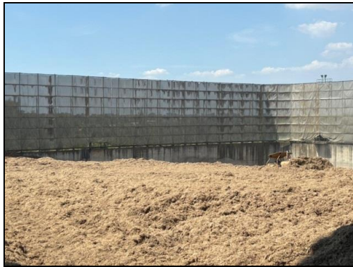
รูปที่ 11 การติดตั้งตาข่ายรอบบริเวณลานกองเก็บขานอ้อย
